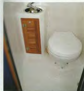
Nasszelle mit Elektro-WC.
